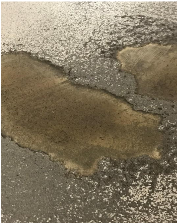
Figur 1.2 Slitageskador på hårdplastbeläggningar efter kort tid i bruk. Foto: Ylva Edwards
