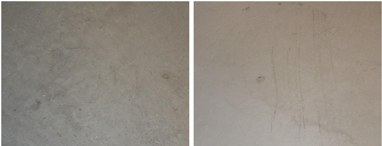
Figur 2.14 Ytligt slitage efter dubbdäck på Polyuretan Conideck 2255 efter 8 år på parkeringsdäcket i Kville
