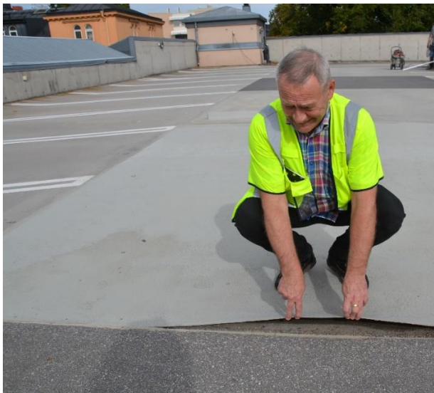
Figur 2.47 Omfattande vidhäftningsläpp
