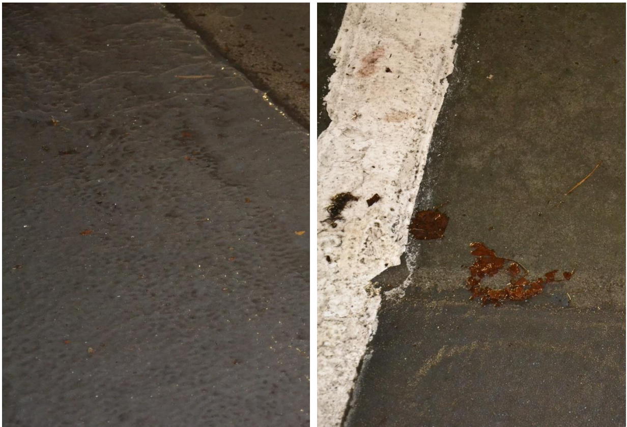
Figur 2.37 Polyurea Micorea efter 7 år på parkeringsdäcket i Åkeshov. Mot ytterkant
