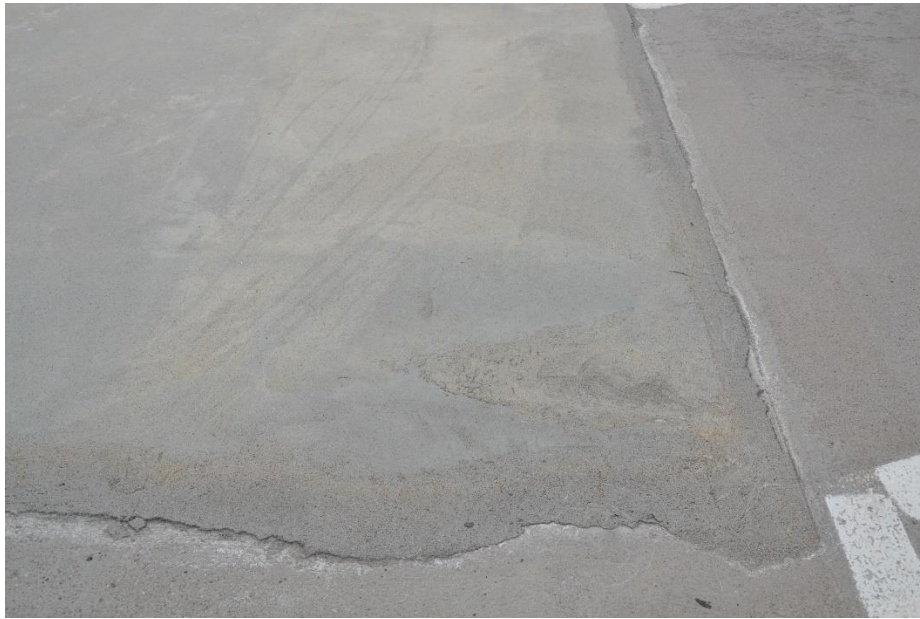
Figur 2.50 Visst slitage och vidhäftningssläpp
