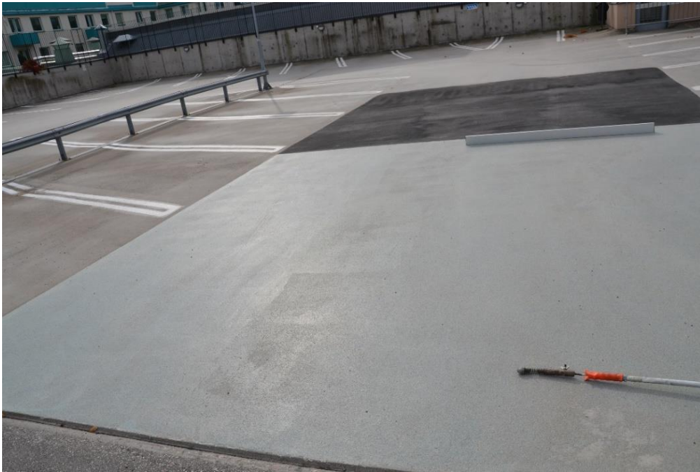
Figur 2.42 Inga indikationer på vidhäftningssläpp noterades
