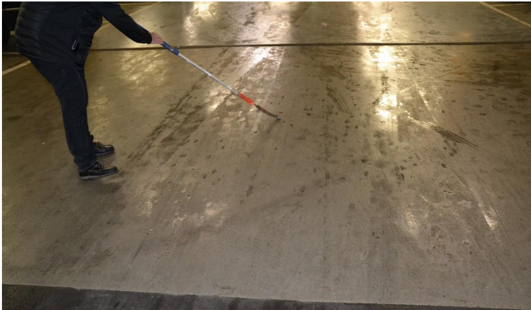
Figur 2.30 Polyuretan Ucrete på parkeringsdäcket i Åkeshov 2021
