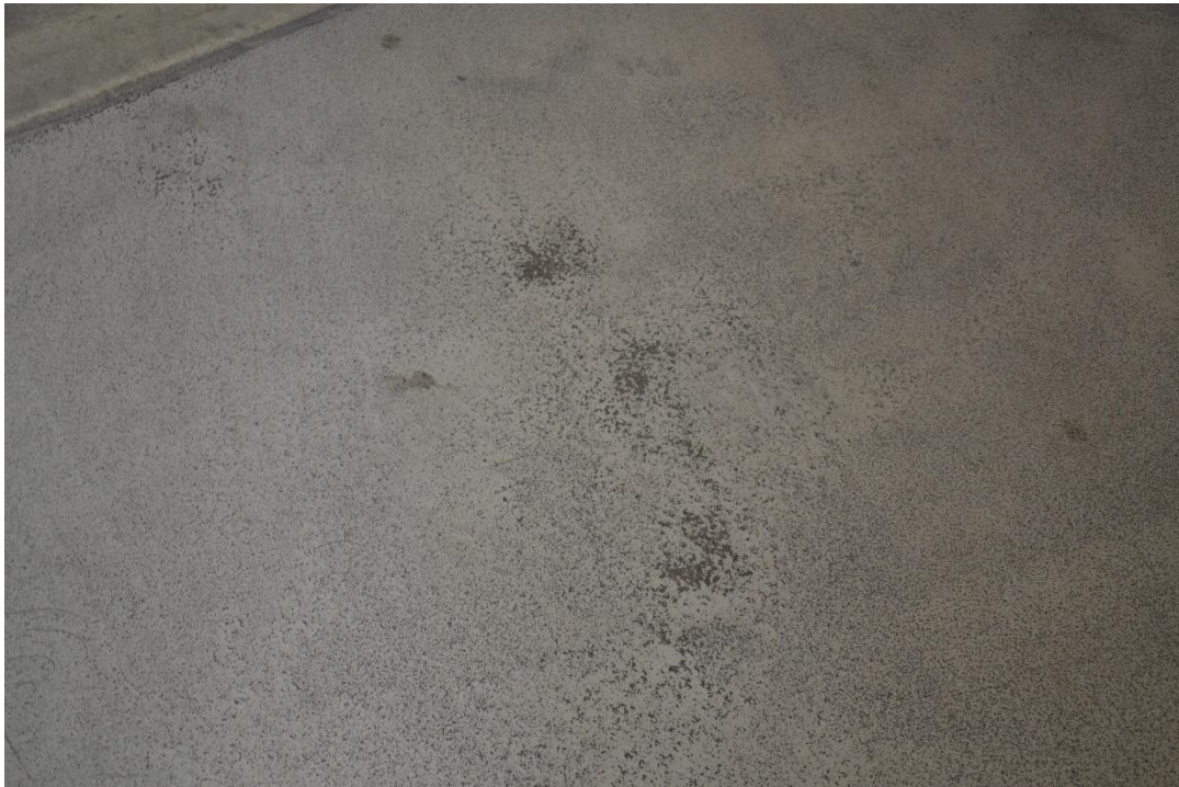
Figur 2.19 Polyuretan Mapefloor PU på parkeringsdäcket i Kville 2021
