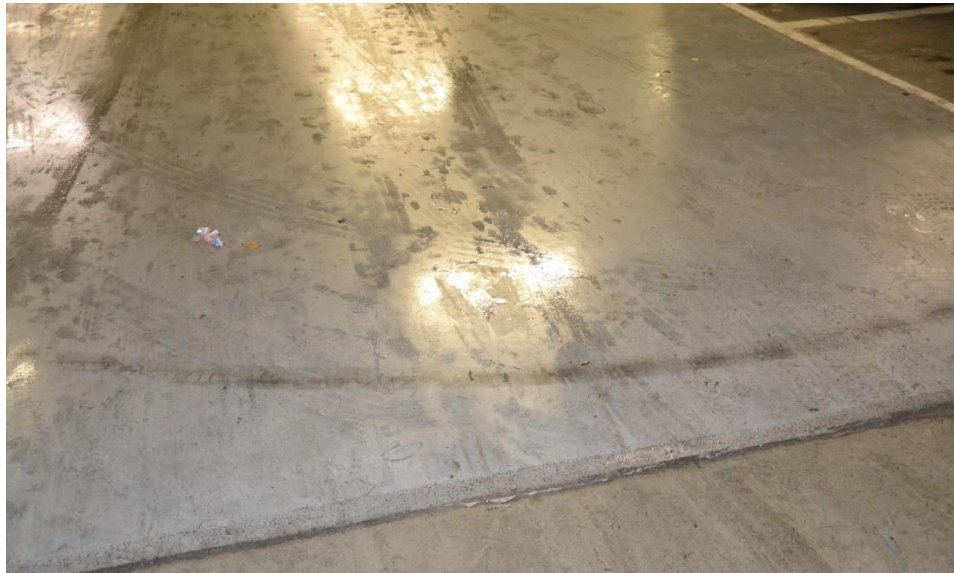
Figur 2.32 Hårdbetong Mastertop på parkeringsdäcket i Åkeshov 2021
