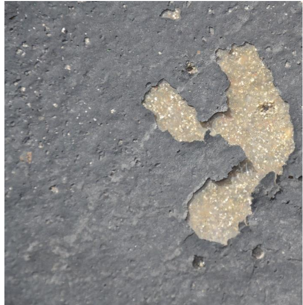
Figur 2.40 Ett mindre vidhäftningssläpp
