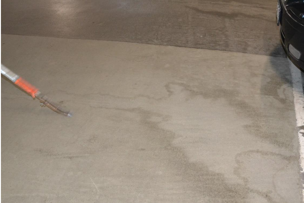
Figur 2.13 Polyuretan Conideck 2255 på parkeringsdäcket i Kville 2021
