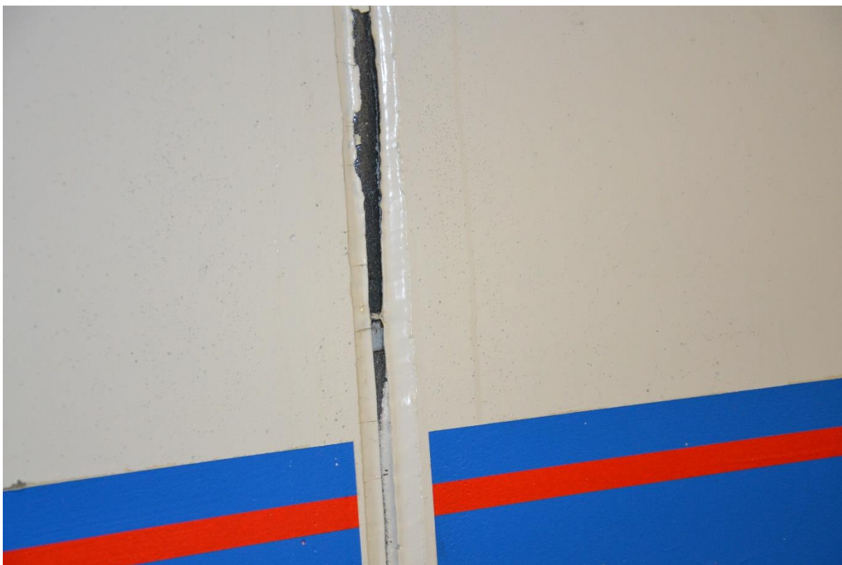
Figur 2.22 Fogning i vägg med otillfredsställande resultat
