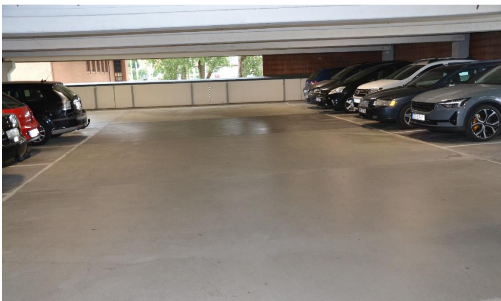
Figur 2.11 Polyuretan Deckshield ID näst närmast i bild
