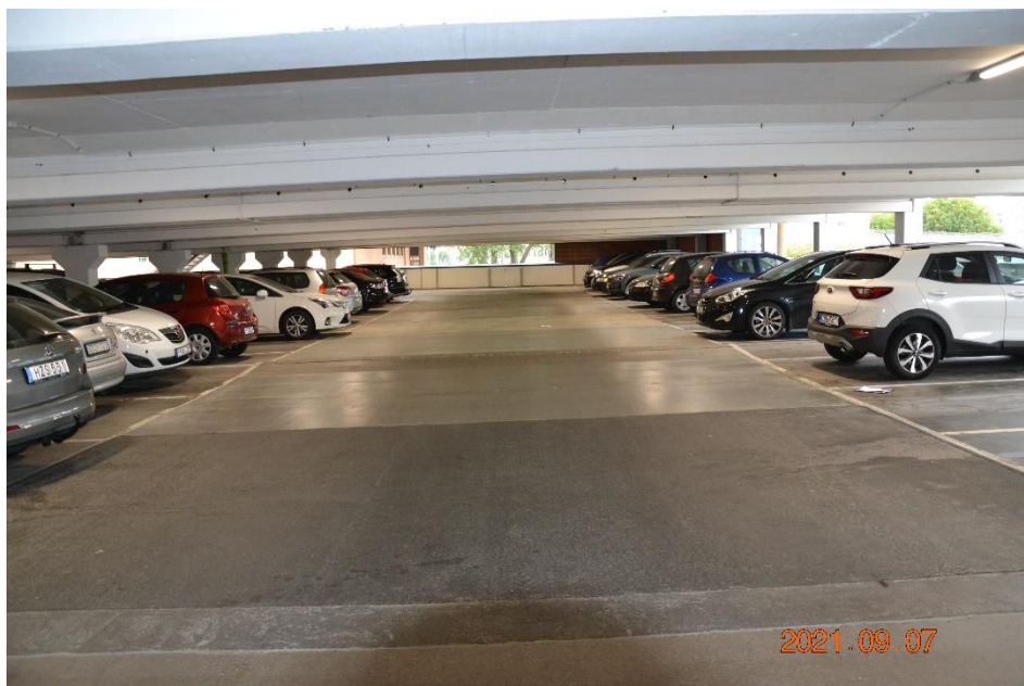
Figur 2.2 Bild tagen från infartsramp, från yta 1 till yta 9 i svängen
