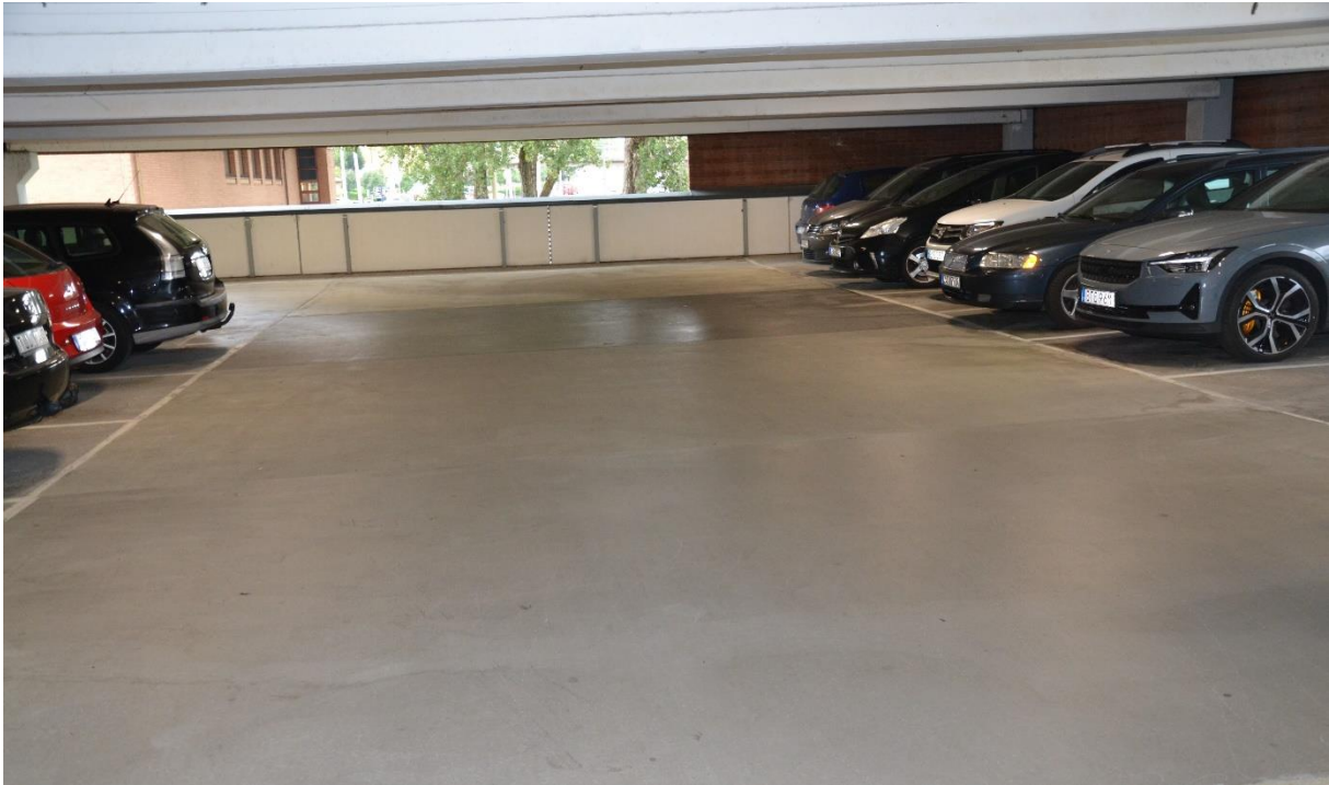
Figur 2.9 Polyuretan StoCretec närmast i bild
