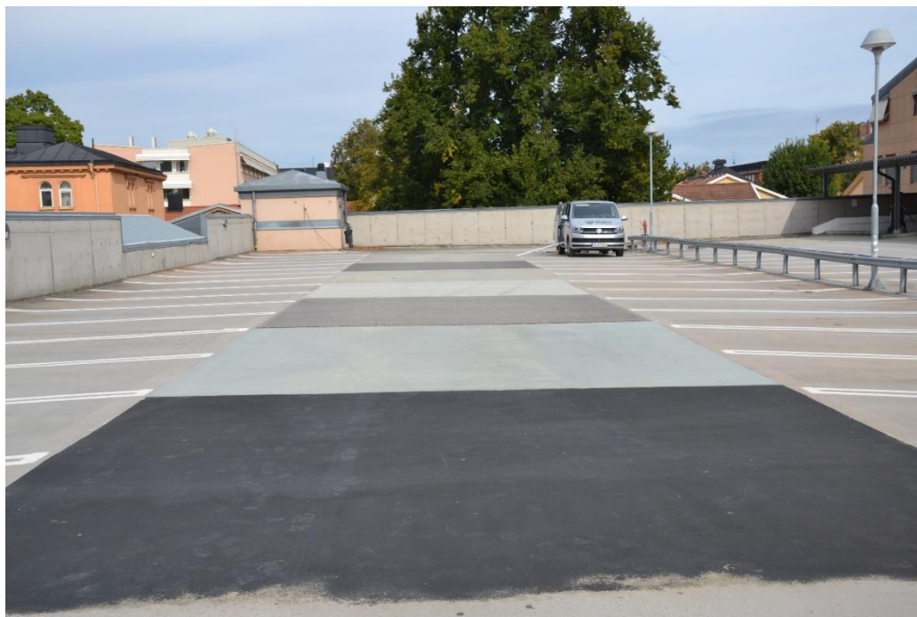
Figur 2.38 Parkeringsdäcket på Baggen 2021
