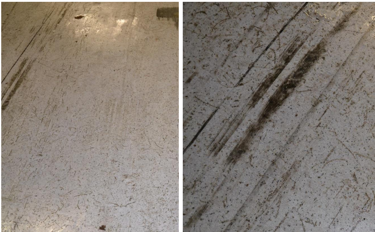
Figur 2.27 Ytligt slitage från dubbdäck samt tidigare burnout på Akryl Silikal Dekor efter 7 år på parkeringsdäcket i Åkeshov
