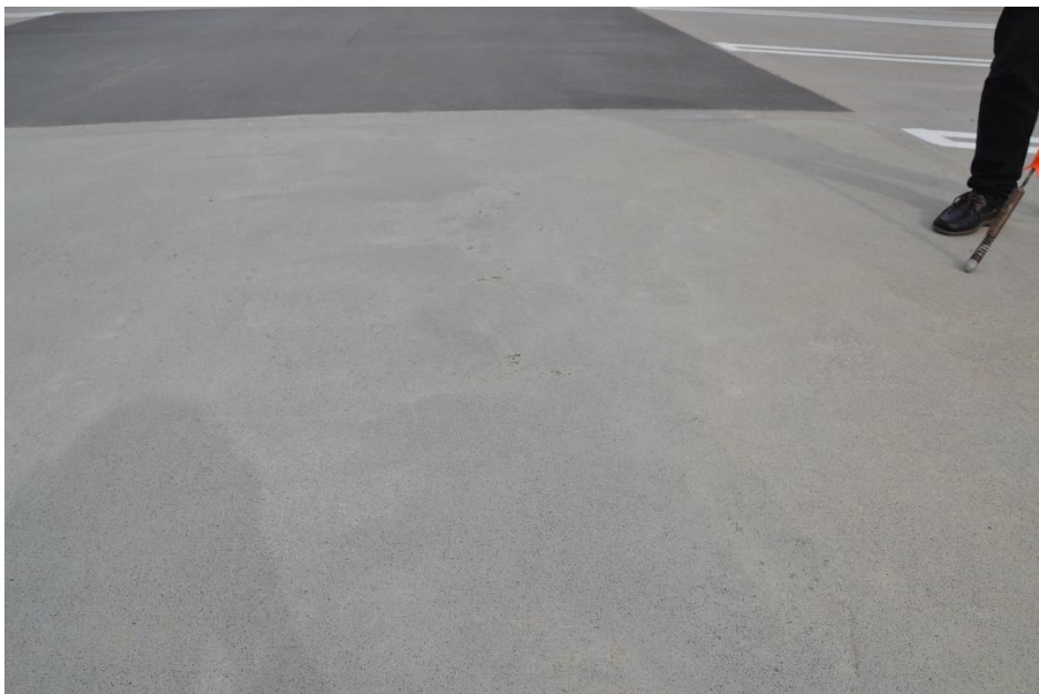
Figur 2.51 Bomkartering avslöjar partier där beläggningen släppt från underlaget
