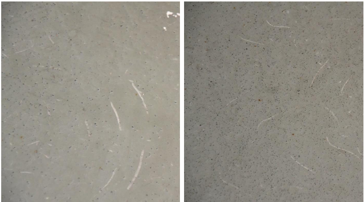
Figur 2.8 Ytligt slitage efter dubbdäck på Polyuretan Sikafloor efter 8 år på parkeringsdäcket i Kville
