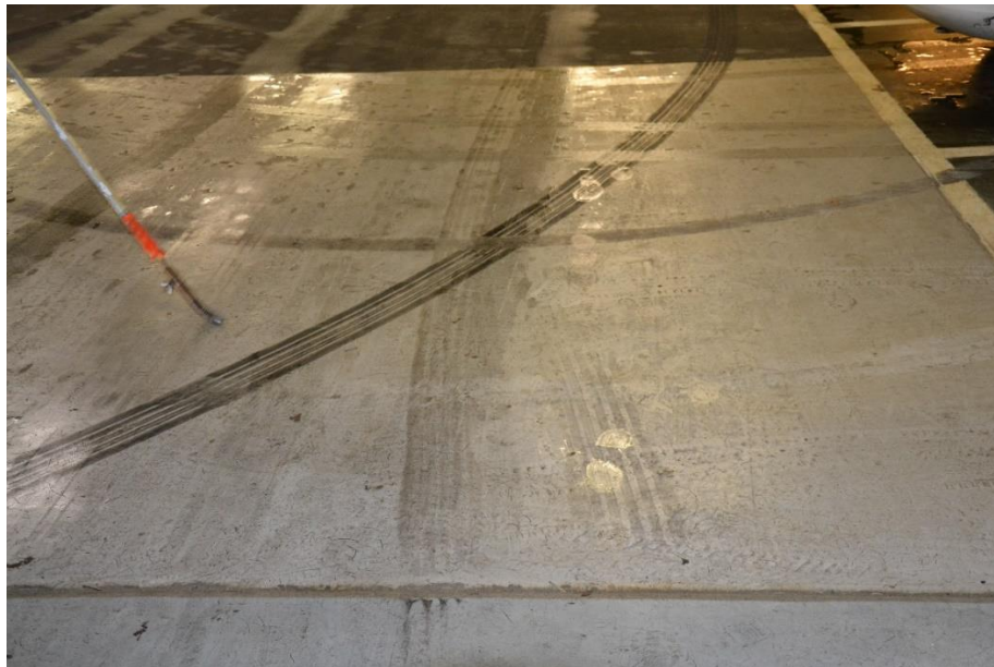
Figur 2.34 Epoxi Micopox på parkeringsdäcket i Åkeshov 2021
