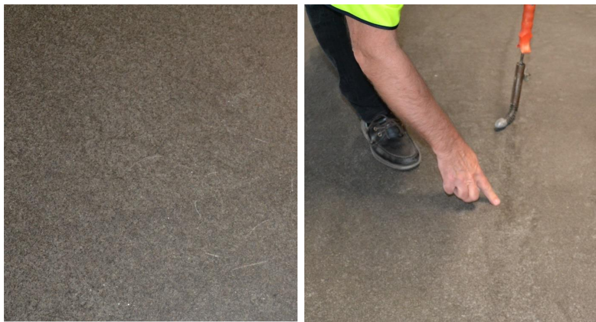
Figur 2.16 Ytligt slitage efter dubbdäck på Akryl Map Pro efter 8 år på parkeringsdäcket i Kville
