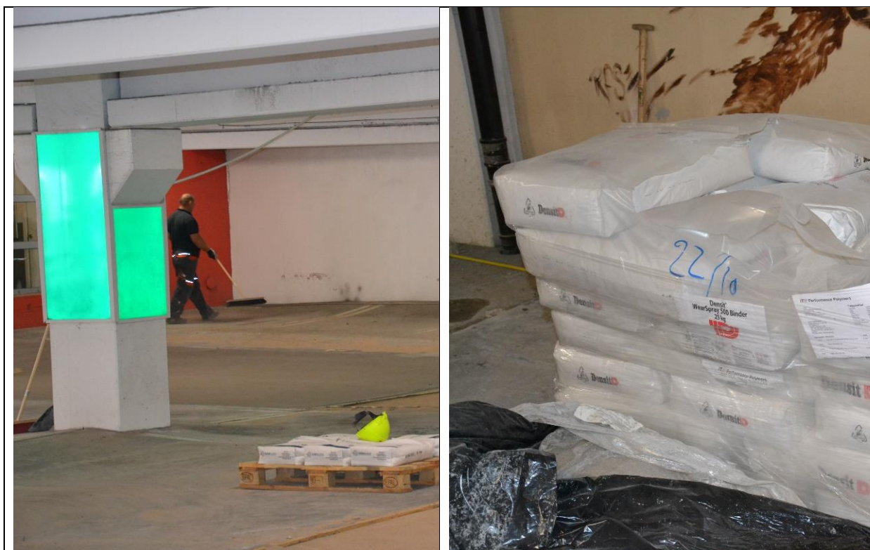
Figur 2.55 Ny beläggning i rampen och på köryta. Valet var Densit 2021
