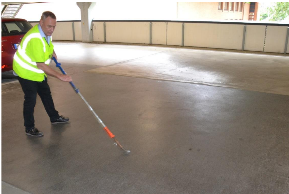
Figur 2.15 Akryl Map Pro på parkeringsdäcket i Kville 2021
