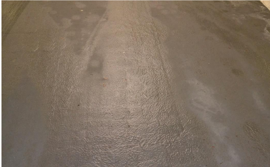
Figur 2.36 Polyurea Micorea på parkeringsdäcket i Åkeshov 2021
